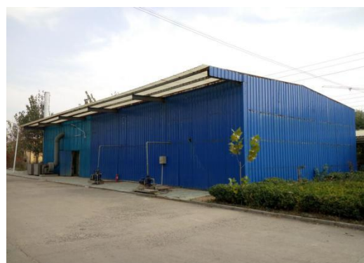
濟南大自然廢水處理廠
