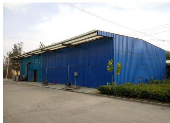
濟南大自然廢水處理廠
