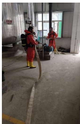
搶險人員現場替換堵漏 洩露二氯甲烷洗消收集至事故池
