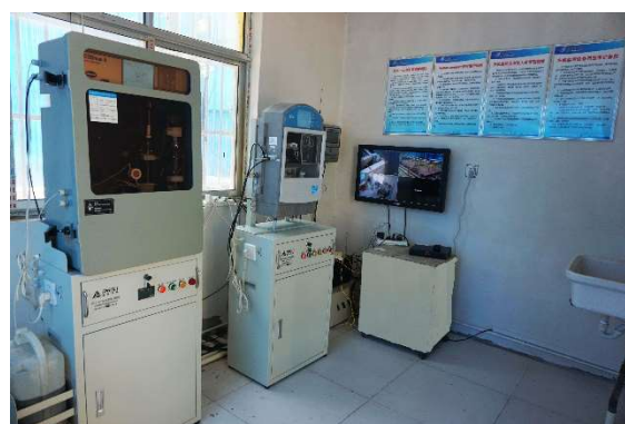
廢水線上監測系統
