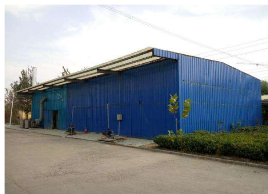
濟南大自然廢水處理廠
